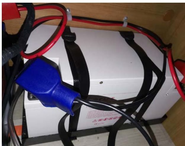
APRÈS : batterie EAZ-E installée
