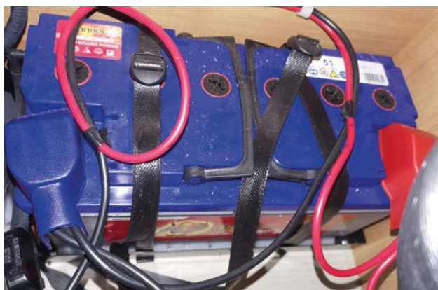
AVANT : batterie plomb installée
