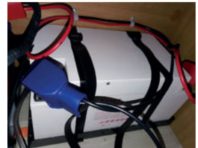
APRÈS : batterie EAZ-E installée
